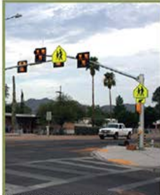
HIGH-INTENSITY ACTIVATED CROSSWALK (HAWK) BEACON / SEÑAL ACTIVA DE CRUCE DE ALTA INTENSIDAD
